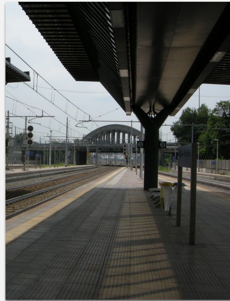
stazione Rogoredo, pensilina (arch. Mangiarotti)
