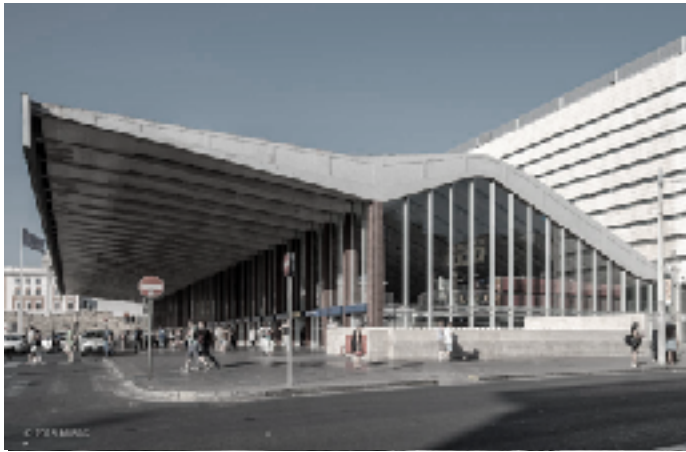
17. E. Montuori, L. Calini, A. Vitellozzi, M. Castellazzi, V. Fadigati, A. Pintonello, Edificio di Testa Stazione Termini , 1950
