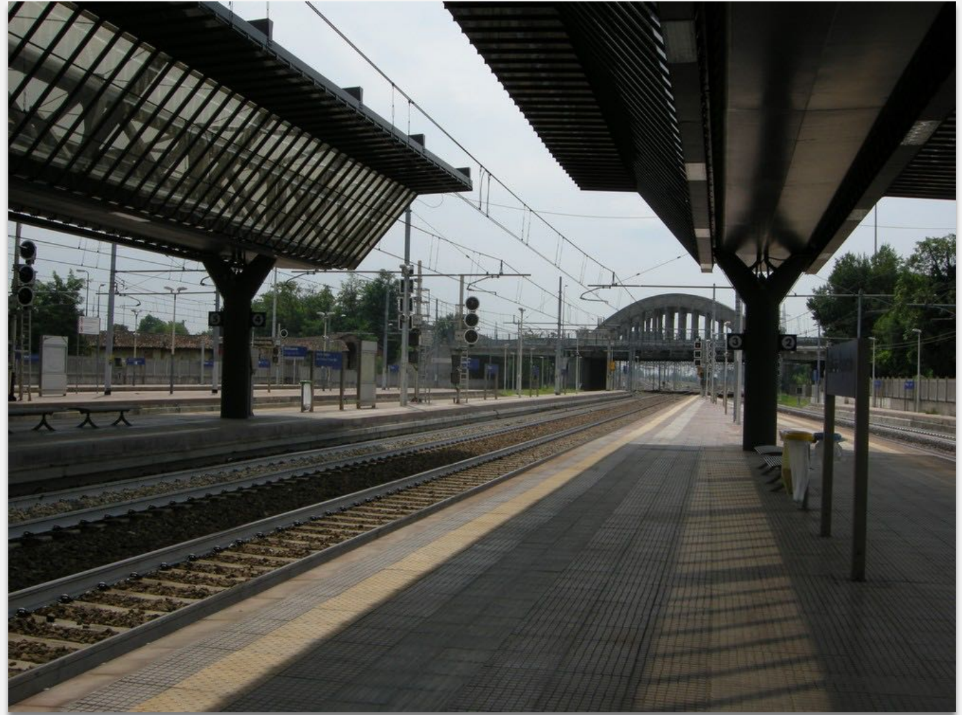
stazione Rogoredo, pensilina (arch. Mangiarotti)
